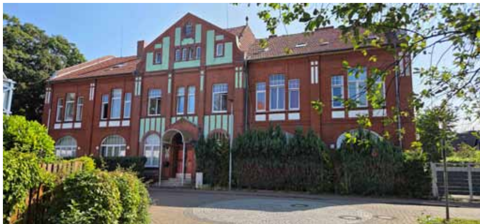
Ehemaliges Verwaltungsgebäude der Alkaliwerke Ronnenberg (Foto: Rudolf Heim)
