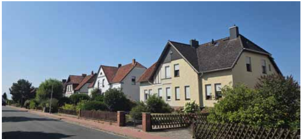
Werkwohnungen der Alkaliwerke Ronnenberg (Foto: Rudolf Heim)
