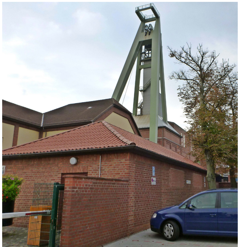
Fördergerüst des Salzbergwerks Grasleben (Foto: Wusel007- Eigenes Werk, CC BY-SA 3.0, https://commons.wikimedia.org/w/index.php?curid=21347550 )
